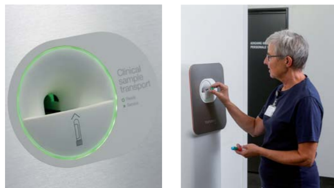
Les tubes de prélèvement sont positionnés dans l'orifice d'entrée de la station Vita.
