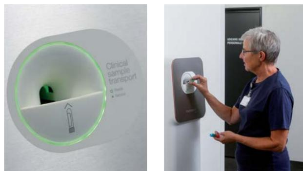
Os tubos de amostra são colocados na abertura de entrada da estação Vita.
