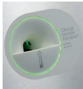
Próbówki umieszcza się w otworze wlotowym stacji Vita.
